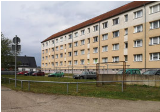
Nebenanlagen im Altneubaugebiet.
