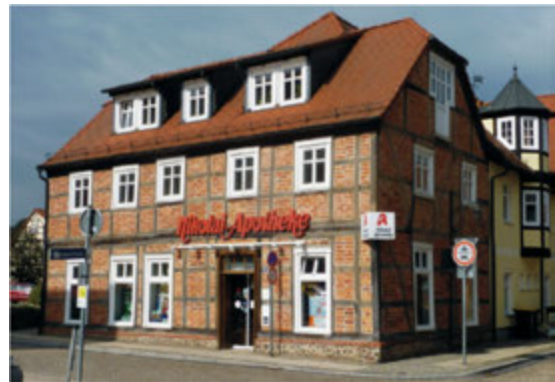
... nach der Erneuerung.
