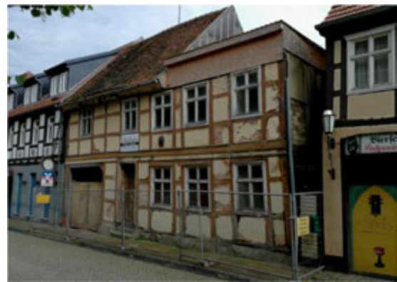
Leerstehendes, unsaniertes Gebäude.
