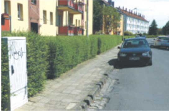
„Altneubaugebiet“ Gehwege aus den 1970 Jahren... .. und Ausbesserungen mit verschiedenen Materialien.
