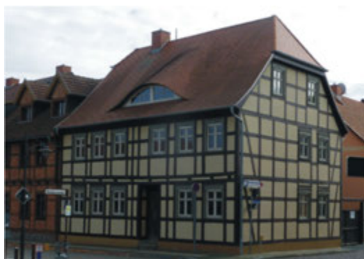
Saniertes Gebäude in der Kirchstraße.....
