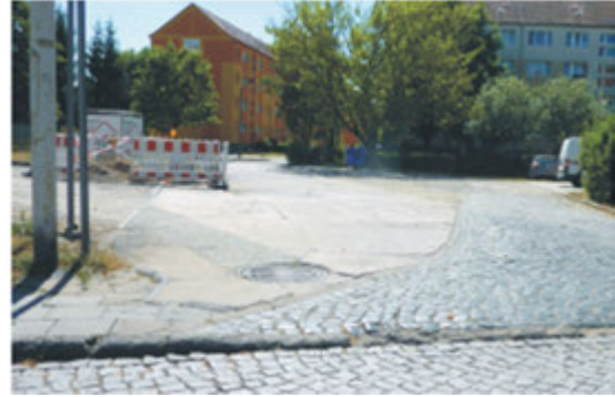
„Altneubaugebiet“ Gehwege aus den 1970 Jahren... .. und Ausbesserungen mit verschiedenen Materialien.
