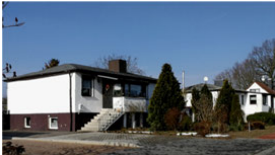
Einfamilienhäuser; Baujahr vor 1990.
