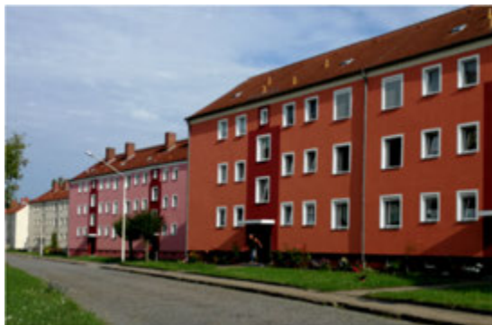
Gebäude in traditioneller Bauweise.
