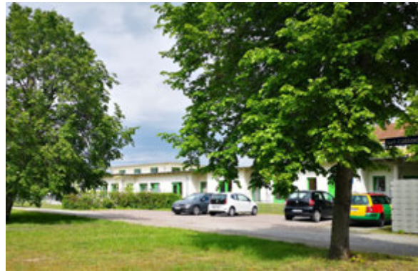
Westansicht des neuen Kindergartens.
