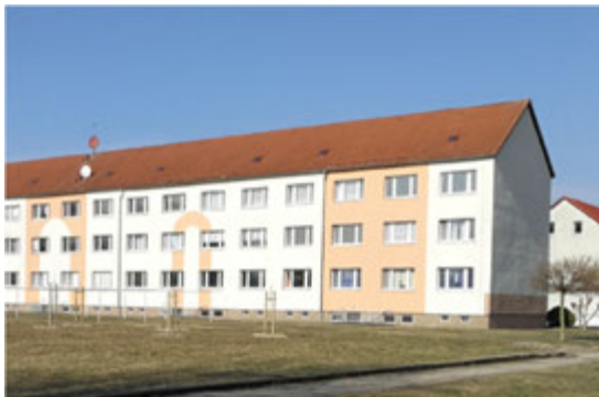
Gebäude in traditioneller Bauweise.
