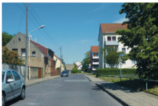
Die Melker Straße vor dem Ausbau 2017
