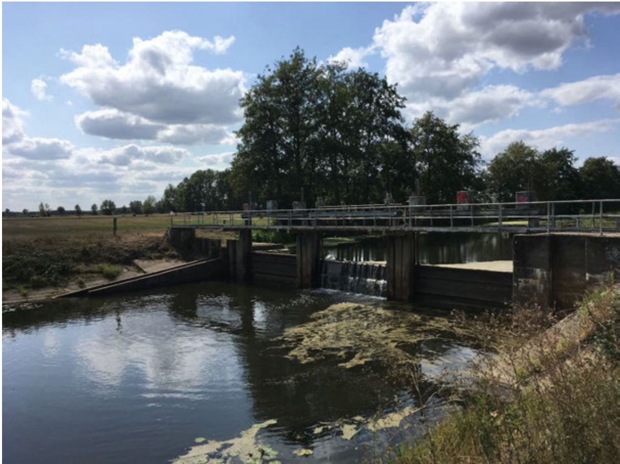
Abb. 7: Wehranlage an der Biese in Schliecksdorf
